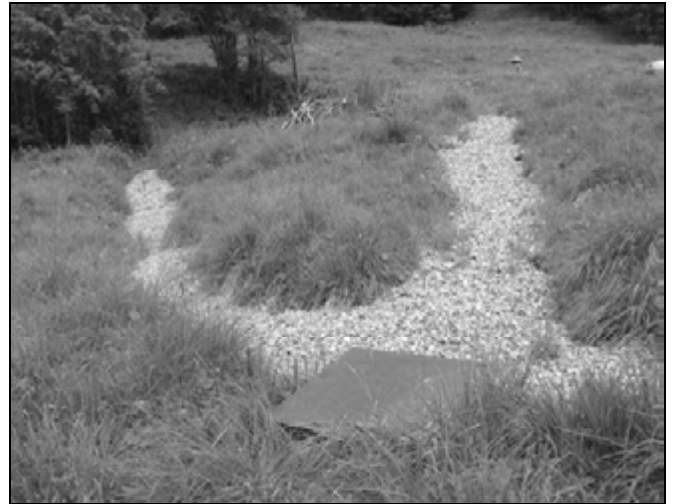
Fig. 4. Enclosing structures: Drainage system to stabilise the sliding layers of the slope/ Structuri de împrejmuire: Sistem de drenaj pentru stabilizarea stratelor care se deplasează pe versant
