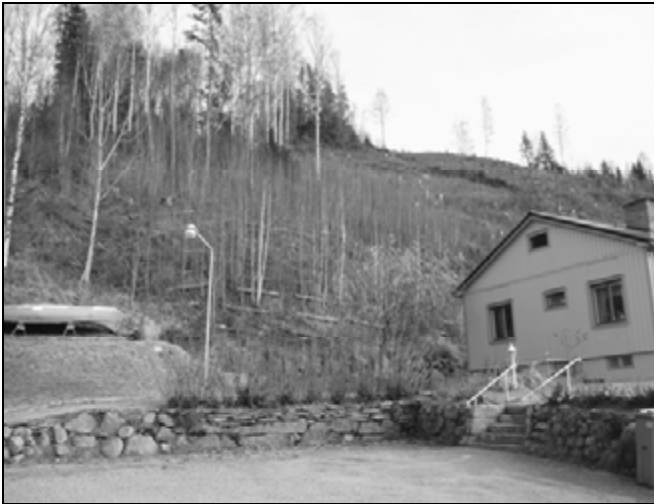
Fig. 3. New building and upgrade: Soil nailing measures to stabilise unsteady slopes (courtesy of Rankka, 2005)/ Clădire nouă și îmbunătățiri: Măsuri de fixare a solului pentru stabilizarea versanților instabili (Rankka, 2005)
