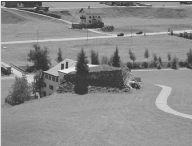
Fig. 5. New building and upgrade: Splitting wedge for splitting and deflecting mass movements/ Clădire nouă și îmbunătățiri: Construcție pentru separarea și devierea maselor în mișcare
