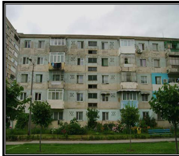
Foto. 2 Aspect inestetic al blocului, cartier Craiovița Nouă
