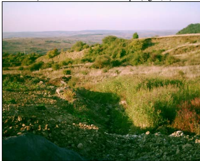
Fig 4. Regressive erosion is threat the road DN1 / Eroziunea regresivă atacă DN1
