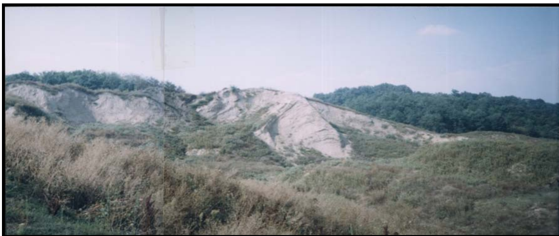
Foto.1 Roșița open pit – landslides from Valea Rogoazelor Cariera Roșița-Valea Rogoazelor alunecări de teren
