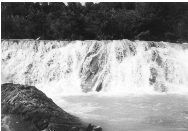
Fig. 1 Rupturi de pantă în apropiere de municipiul Câmpina /Knicks in the neighbourhood of Câmpina
